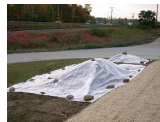
Tas de terre recouvert d'une toile. Source: RAPPEL (2003)
