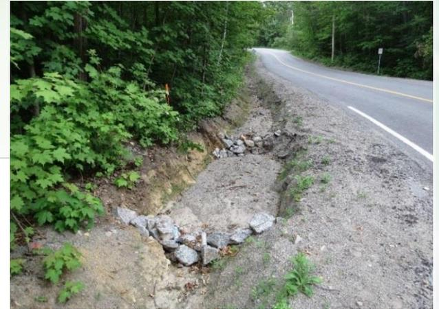
Nettoyage des trappes à sédiments
