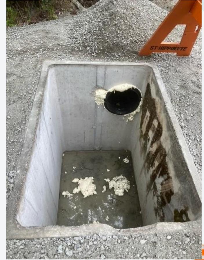
Deux ponceaux de 18 pouces, en amont et en aval, sont installés pour la circulation de l'eau.
