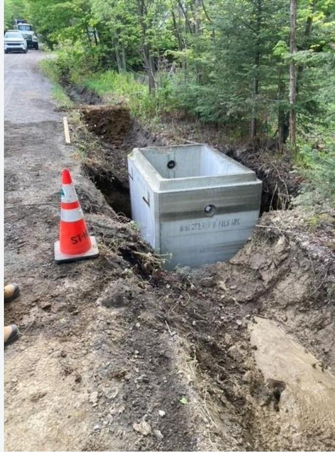
Une des deux fosses de béton est mise en place au coin de la 85<sup>e</sup> Avenue et rue Desjardins.
