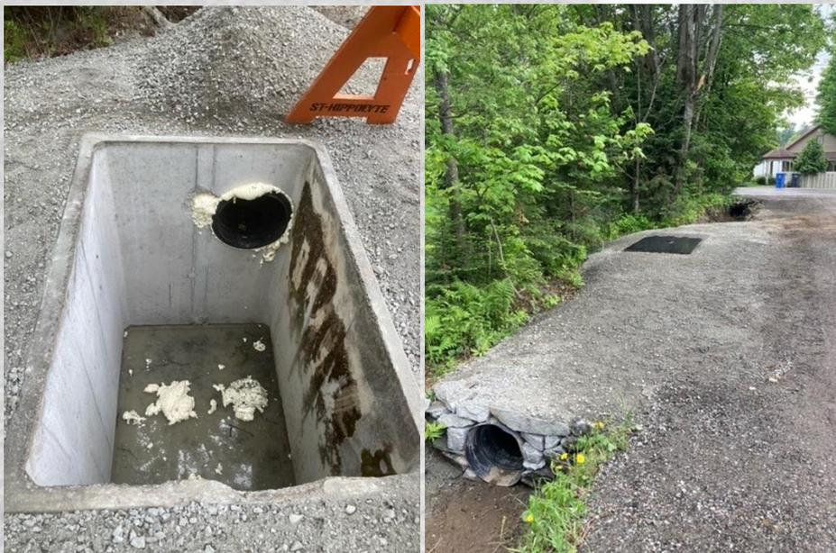
Récupération de fosses avec des défauts de fabrication d'une dimension de 1.2 m X 1.8 m X 1.8 m de haut.
