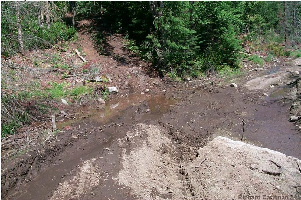
**Photo 7.** Fossé routier mal conçu provoquant, durant la crue printanière, l'érosion du terrain et transportant des quantités importantes de sédiments et d'éléments nutritifs vers le prochain lac. Municipalité de Val-Morin.
