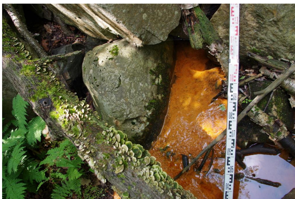
Photo 5 La percolation des eaux peut être observée au pied aval de la digue.
