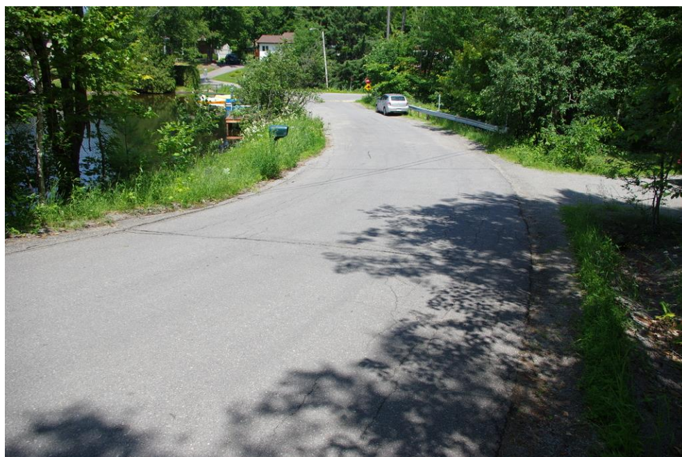
Photo 2 Vue générale sur la digue à partir du sud.
