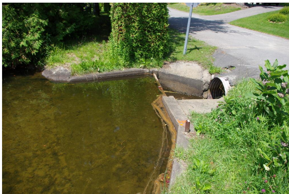
Photo 6 Déversoir du barrage suivi d'une conduite ovale. On remarque une faible dénivelée entre le niveau d'eau et la crête de la digue.
