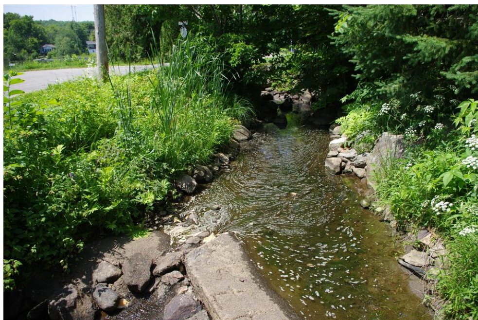
Photo 7 Le canal parallèle au chemin du lac Maillé se termine par un seuil en béton.
