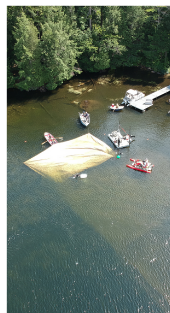
Contrôle : Pose de toiles de jute
