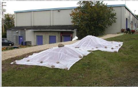
Protéger les tas de terre excavée avec une toile ou une barrière à sédiments fins.
