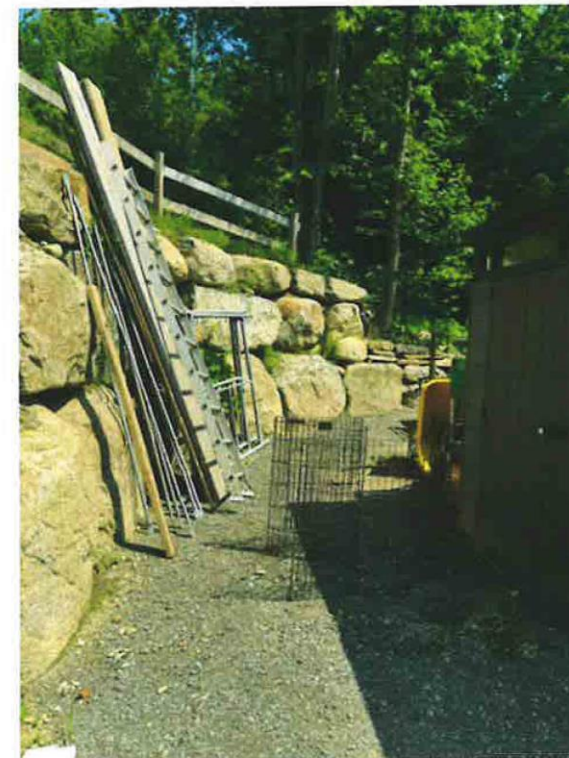
Muret mitoyen avec le 37, Aubrisson Nord
