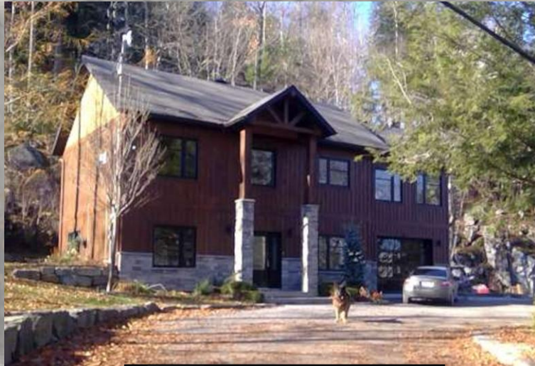
Bâtiment principal (existant)
