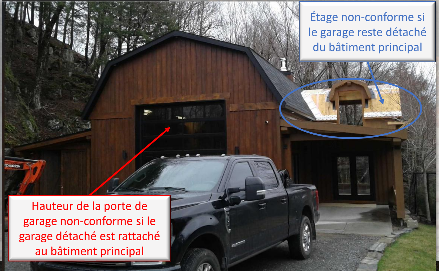
Garage détaché (existant)
