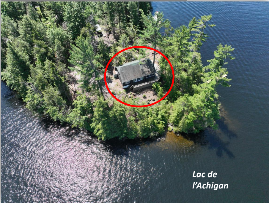
Vue aérienne (existant - 53, 330 e Avenue)
