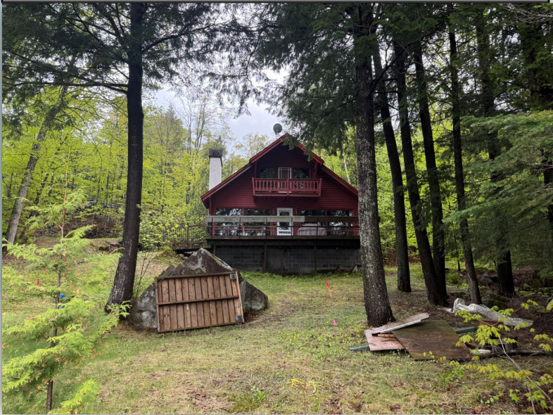
Maison existante (à démolir)
